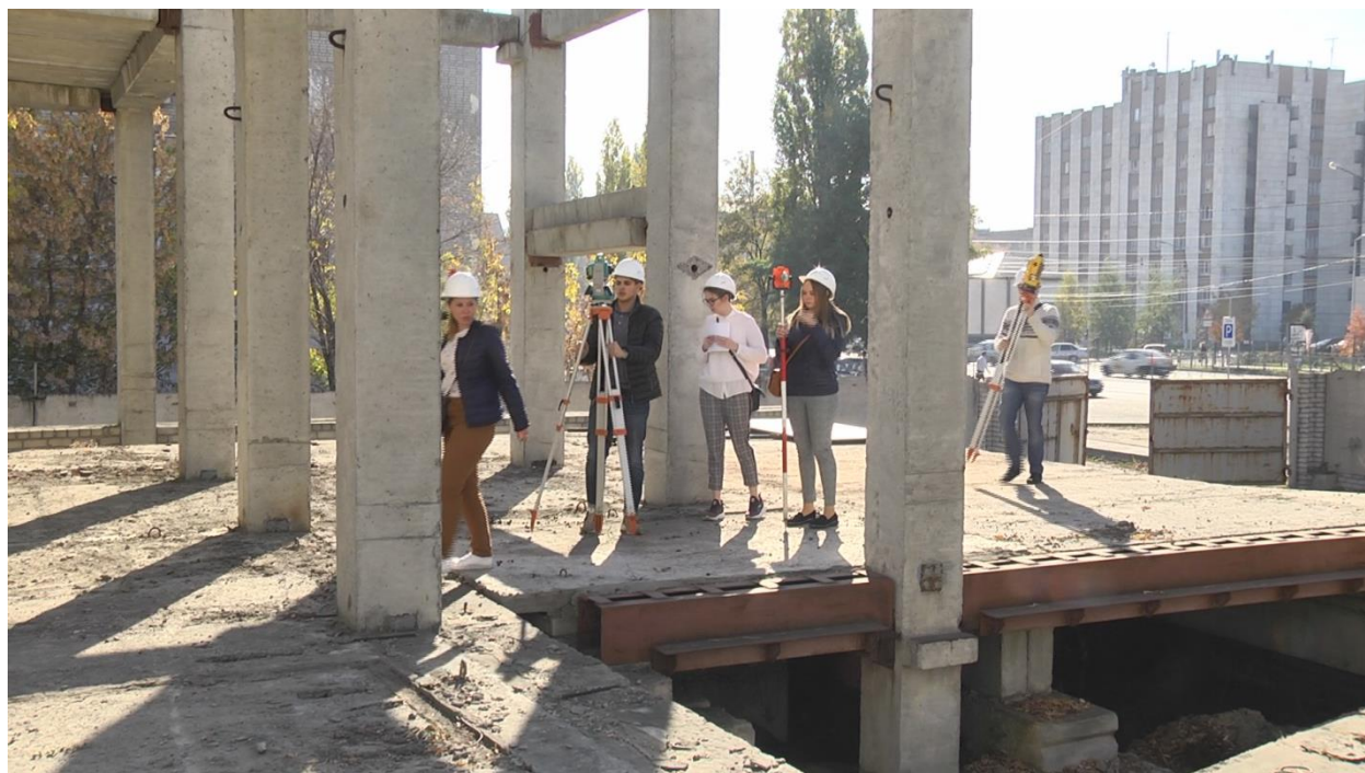
Студенты проходят практику на строительной площадке второй очереди 7 корпуса. Сентябрь 2016 г.
