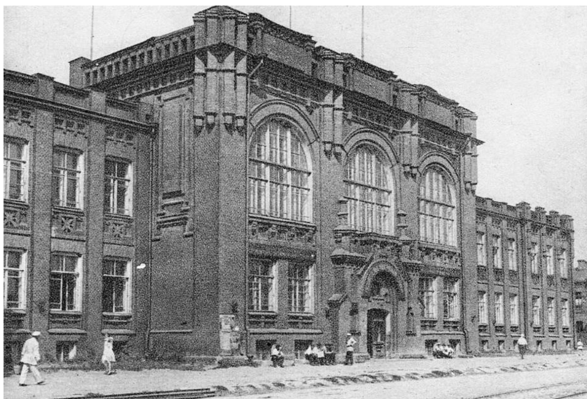
Здание городского среднего механико-технического училища. 1920-е гг.
