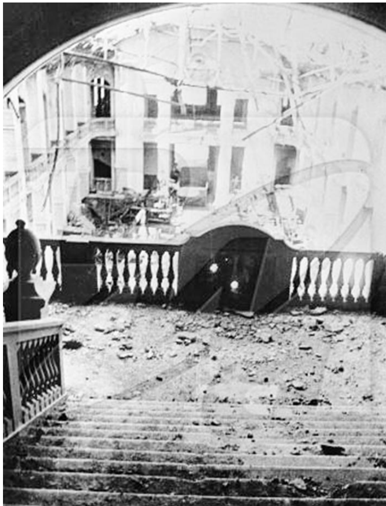
Разрушенные учебные корпуса ВСХИ. 1943 г.
