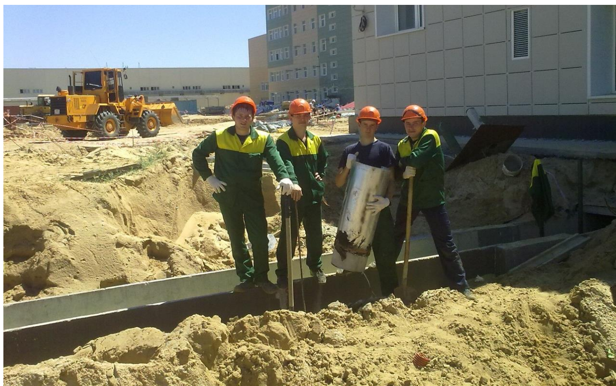
ССО. Нововоронежская атомная станция. 2014 г.
