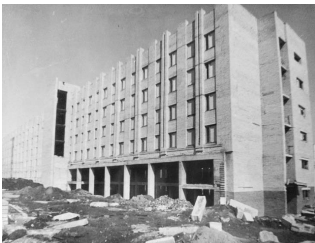
Строительство первого корпуса
