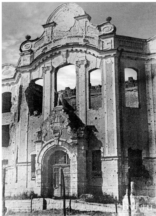
Разрушенные учебные корпуса ВСХИ. 1943 г.
