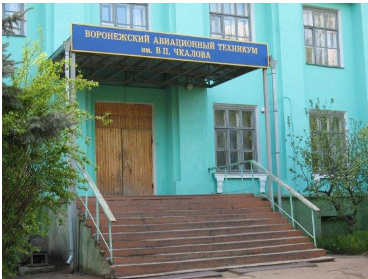
Современный вид входной группы училища
