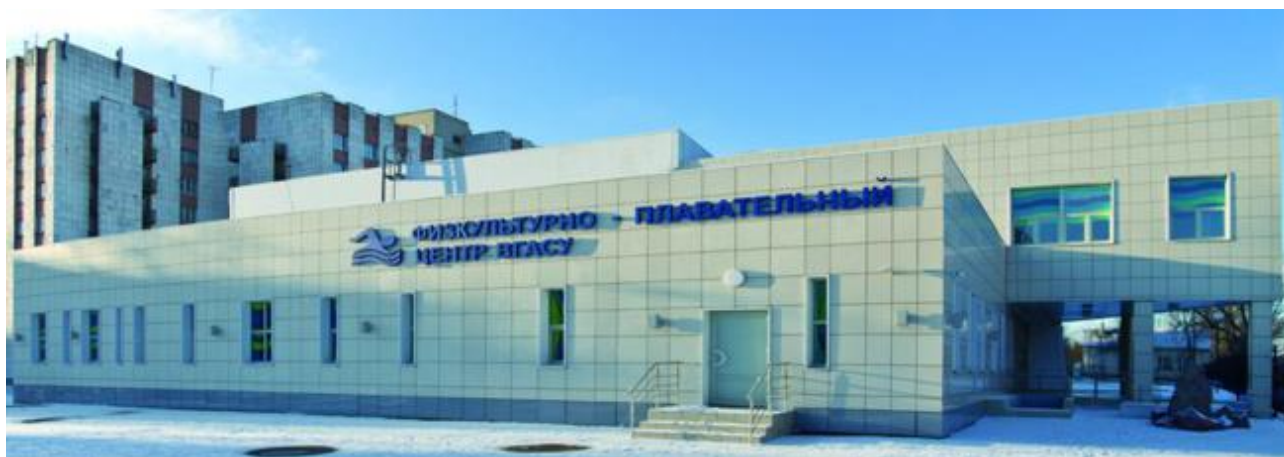
Физкультурно-оздоровительный комплекс ВГАСУ с плавательным бассейном. Сдан в эксплуатацию в 2011 г.
