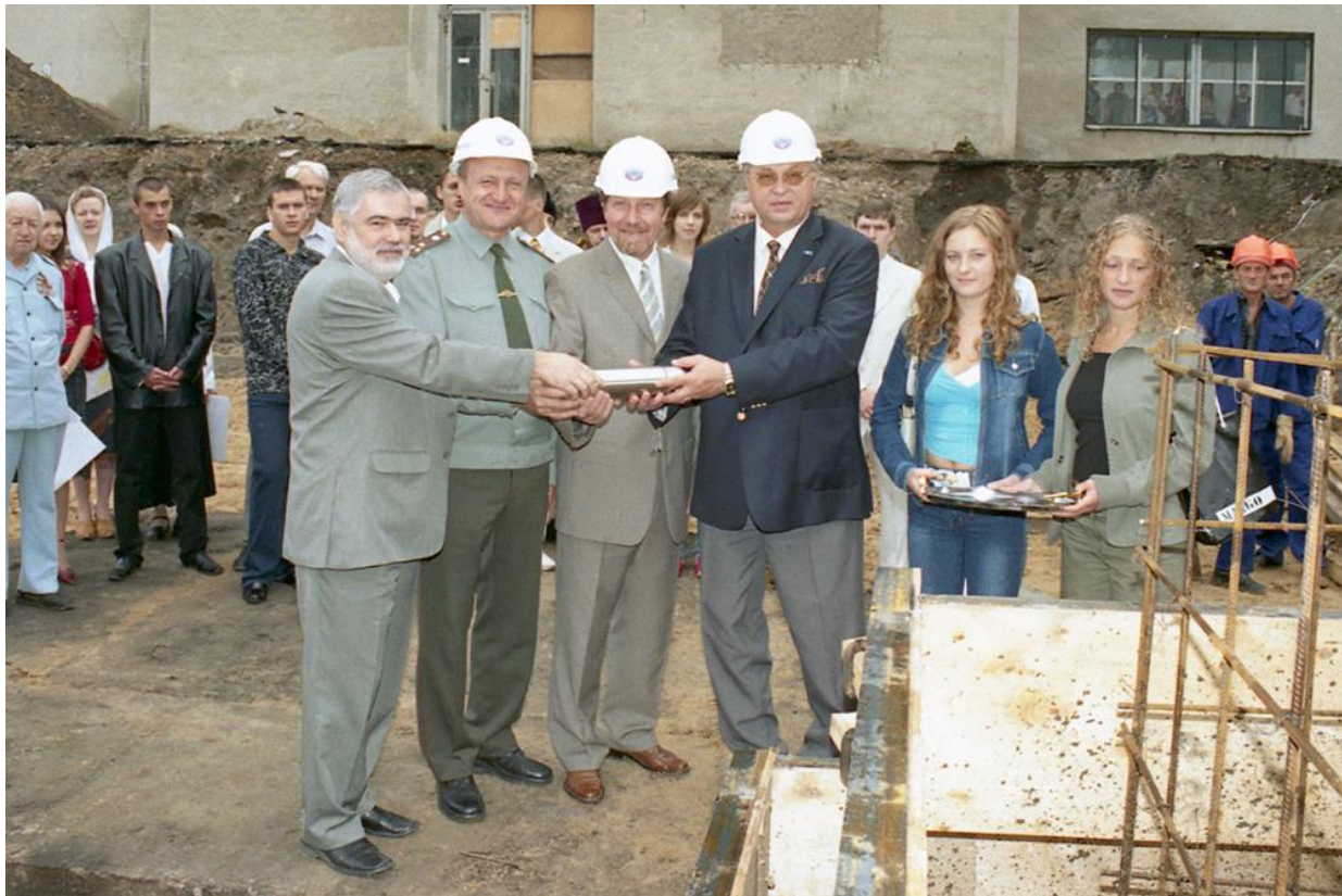
Закладка капсулы при начале строительства 7-го корпуса. 2004 г.
