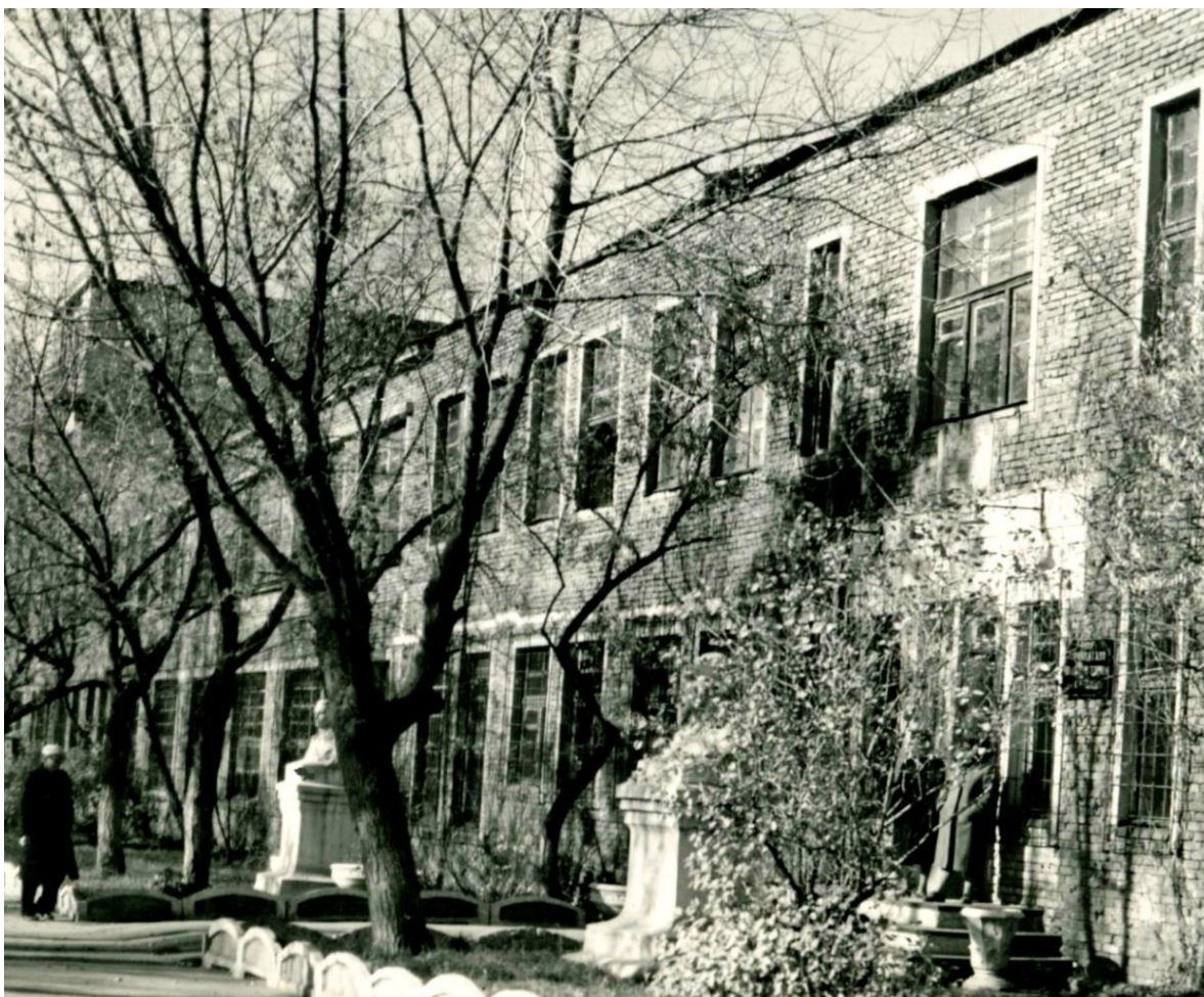
Лабораторный корпус по ул. Циолковского. 1950-е гг.
