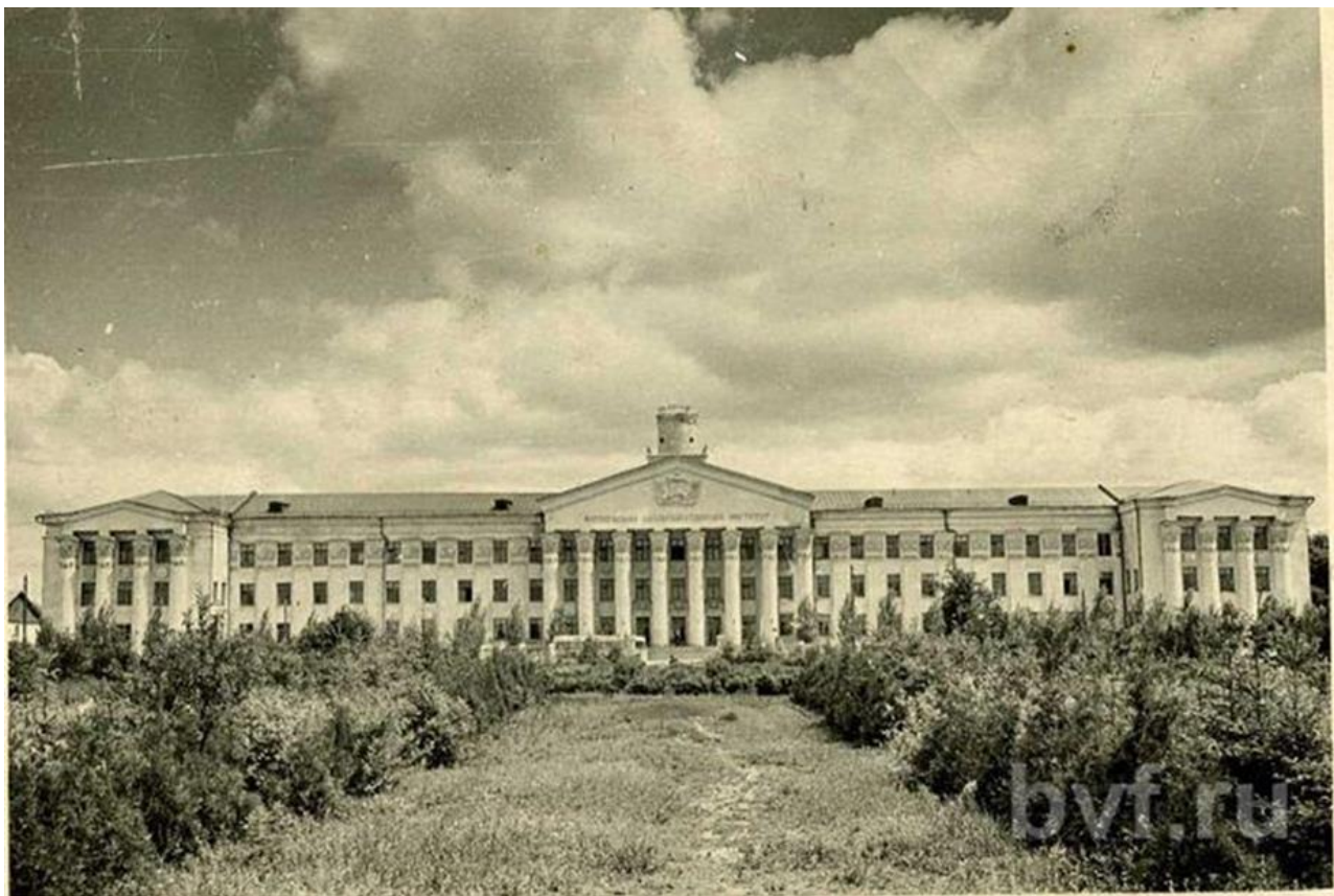
Здание Лесотехнического института. 1930-е гг.
